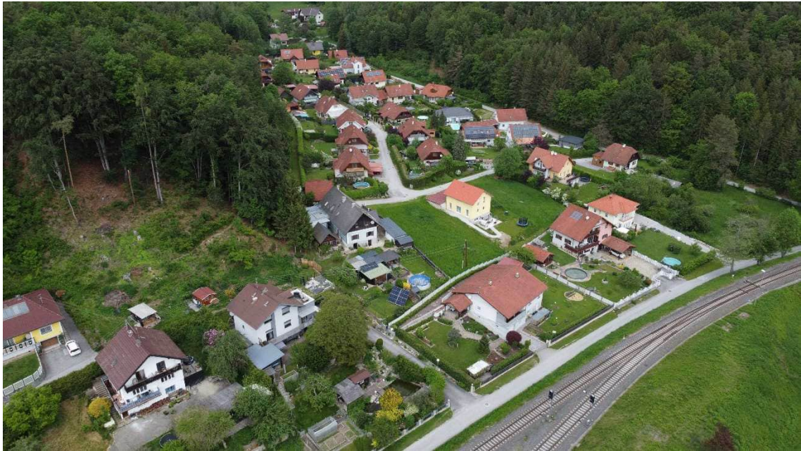
Untere Bahnstraße (Blickrichtung Norden)
