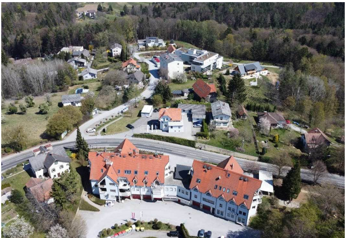
Hauptstraße – Johann Koglerweg (Blickrichtung Osten)
