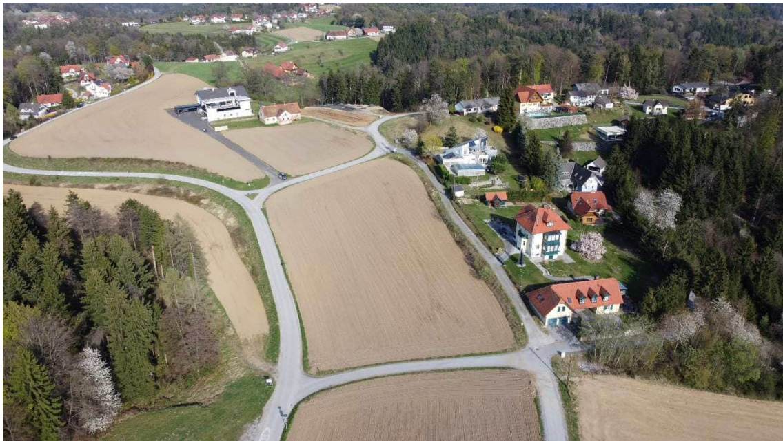
Greimelweg (Blickrichtung Osten)
